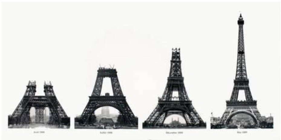
Construction de la Tour Eiffel
