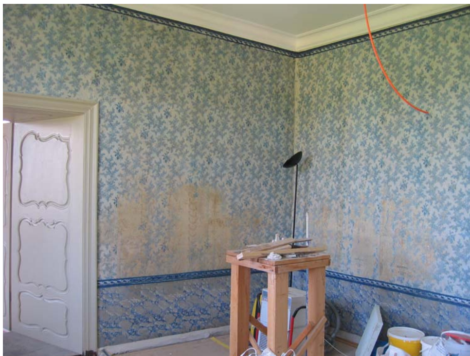
Fig. 4 : Château de Mézières (CH), chambre bleue après remise en place du papier peint imprimé en taille-douce du début du XIX e siècle, déposé suite à l'infestation de mэрule, © Anne-Catherine Page.
