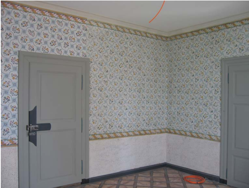
Fig. 5 : Château de Mézières (CH), chambre avec papier peint de la fin du XVIII e siècle ; la moitié du papier a pu être restaurée directement sur le mur, tandis que la seconde partie, totalement ruinée, a été refaite à l'identique (sérigraphie) avec les couleurs d'origine découvertes sous la partie cachée par la bordure, © Anne-Catherine Page.
