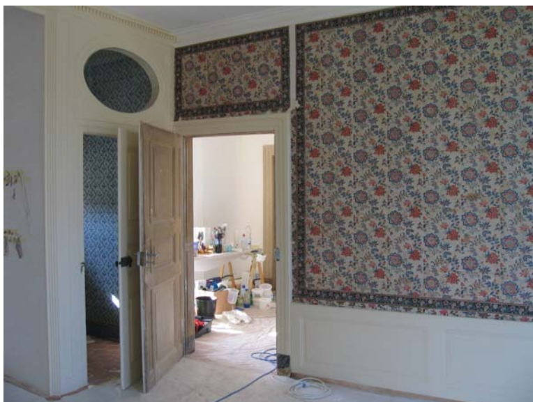
Fig. 3 : Château de Mézières (CH), chambre des indiennes après remise en place du papier peint de 1789 déposé suite à l'infestation de mэрule, © Anne-Catherine Page.
