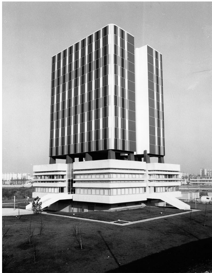
Bâtiment d'archives du Val-de-Marne Architectes Roux-Dorlut, Badani
