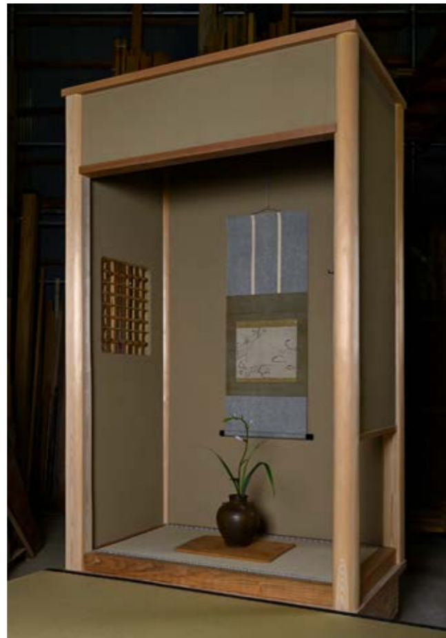
Unité de tokonoma (alcôve) — Entreprise Yamasho, fabricant. Masaki TATENAKA, artisan charpentier, Japon, 2022 Cèdres Kitayam, cèdre rouge, pin, sophora du Japon, roseaux, bambou, torchis, jonc d'igusa, textile, métal; taille à l'herminette. Collection Yamasho © Yamasho
